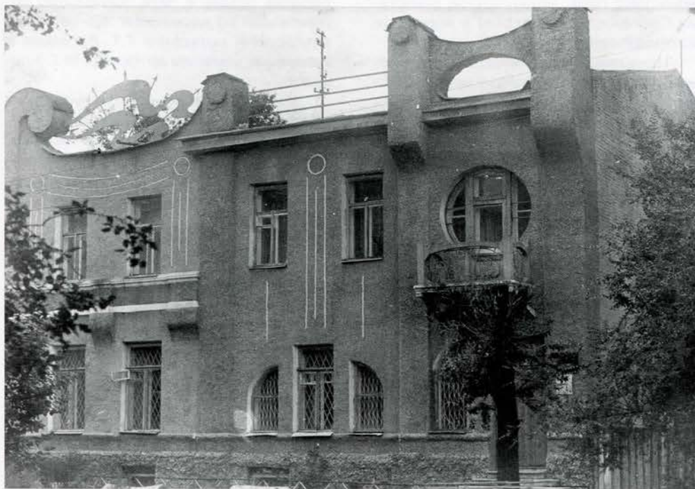
ГПО ул. Амурская, 106
